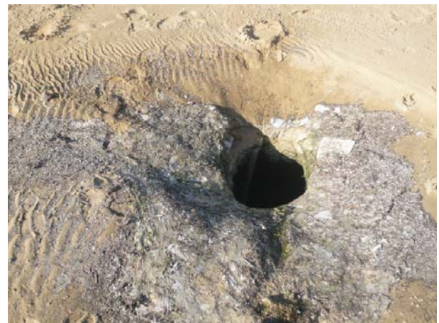
SALIDA DE RESIDUOS CONTAMINACION DEL MEDIO AMBIENTE.
