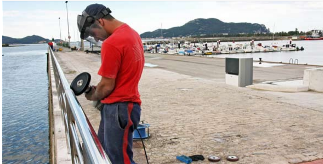
Un operario en los trabajos de instalación de las barandillas. / BEDIA
